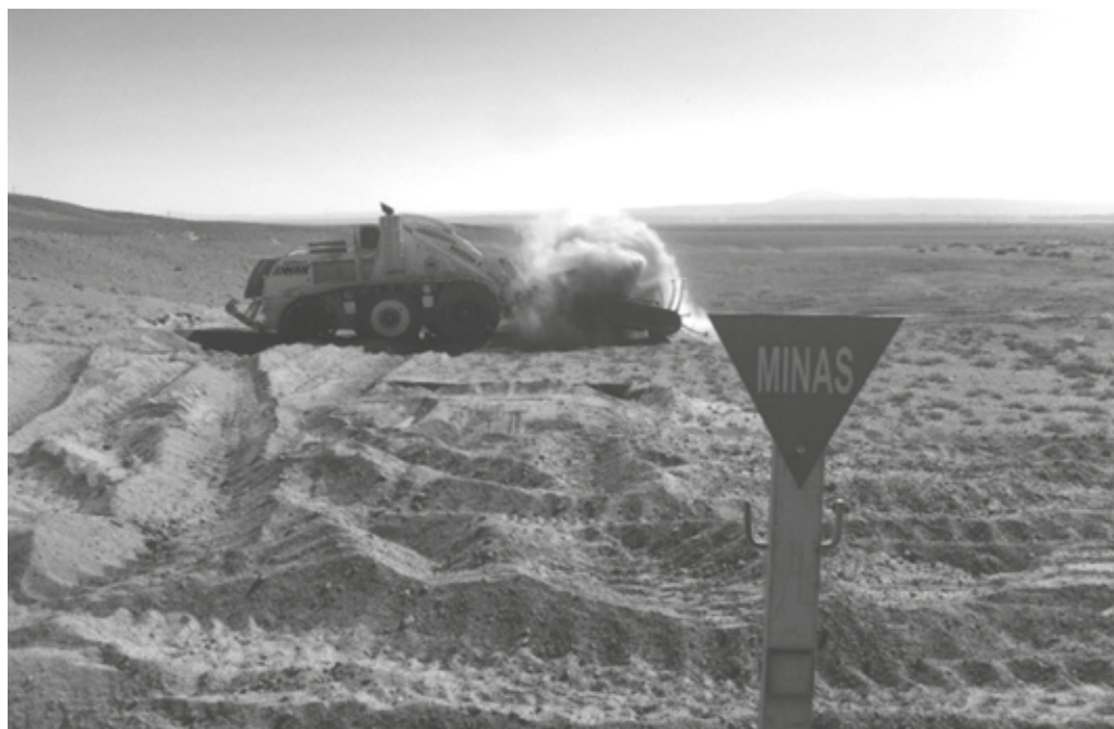
★ Labores de desminado utilizando maquinaria de barrido en el extremo norte de Chile
