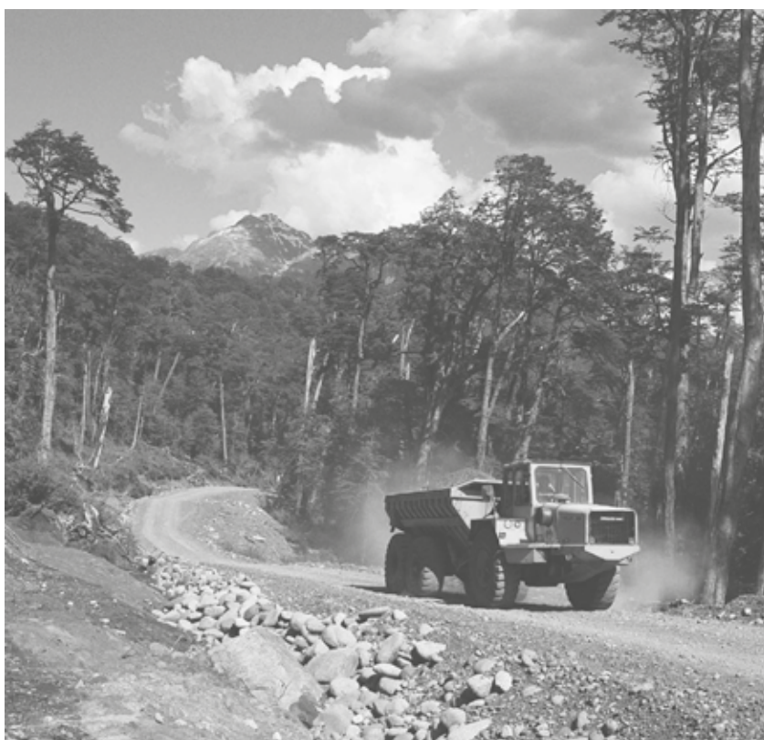
* Faena de construcción de la Carretera Austral en el extremo sur de la Región de los Lagos
