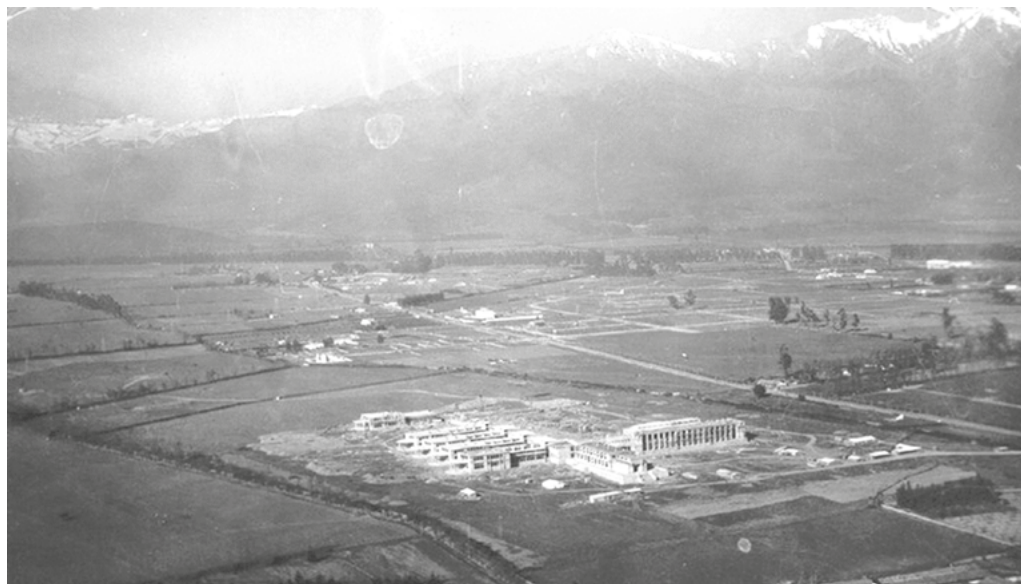
* La Escuela Militar en etapa de construcción en el antiguo fundo de San Luis, Las Condes
