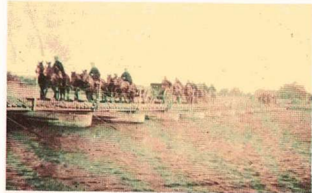
Puente de circunstancias construido por el Grupo de Ingenieros Membrillar, para el cruce del río por la artillería.
