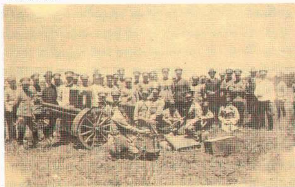
Instrucción con material "Schneider" 7.5 de montaña.
