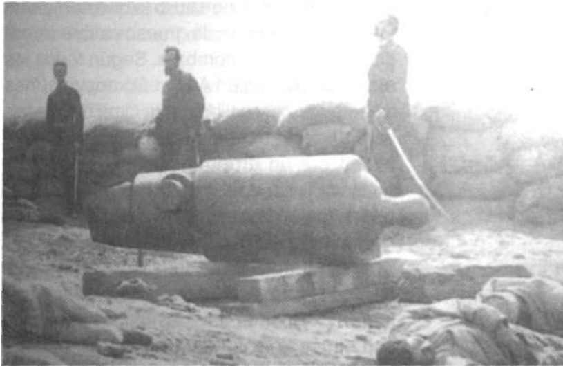
Detalle de la misma fotografía que la anterior. Se muestra un cañón Voruz reventado y volteado, todo indica que fue el accidentado el 17 de marzo de 1880. (M.H.N)
