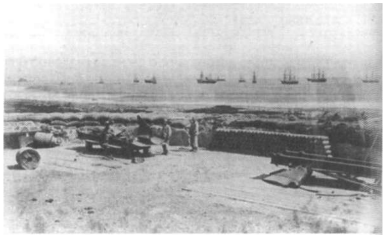
Cañones destruidos en Batería San José. Corresponden a los restos de dos Parrott de 150 lb. Se observa a la izquierda las culatas de ambos, y al centro y la derecha los montajes y las gualderas de las cureñas retorcidas por la explosión. Al fondo, a cubierto de los fuegos desde el mar por el muro de la batería, una gran cantidad perfectamente acumulada de proyectiles de 8" para el uso de estas piezas. (M.H.N)
